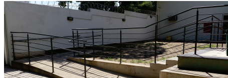
Foto 8 e 9- Responsabilidade Social: Sinalização, rampas de acesso para cadeirantes, placas indicativas para saídas de emergência, porta corta fogo, extintores e reforçou a segurança nos para peitos, etc.
